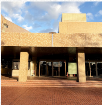
市民会館入口
